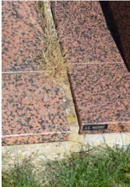
Intertombe bétonnée, un travail de maçonnerie limitant le travail manuel.
