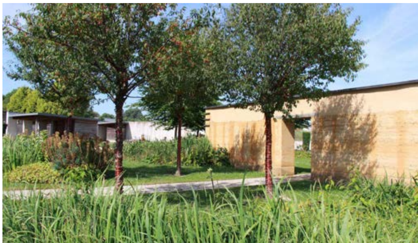
Murs en terre crue servant de columbariums, cimetière d'Audrieu (maîtrise d'œuvre : La Fabrique des Paysages).
