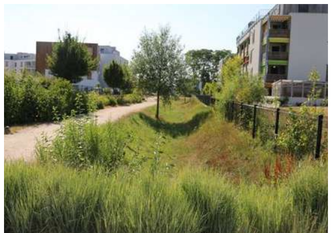
Un exemple de noue d'infiltration Source et crédit photo : Agence de l'Eau Rhin-Meuse
