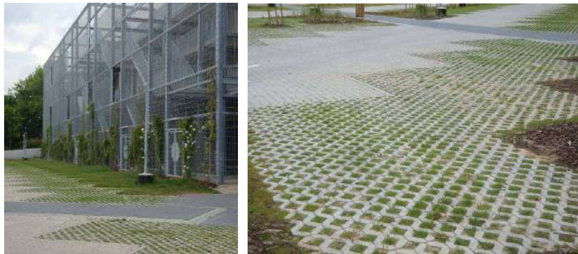
Doorlatende parkeerzone van grastegels in Sint-Lambrechts-Woluwe (Cameleon)
