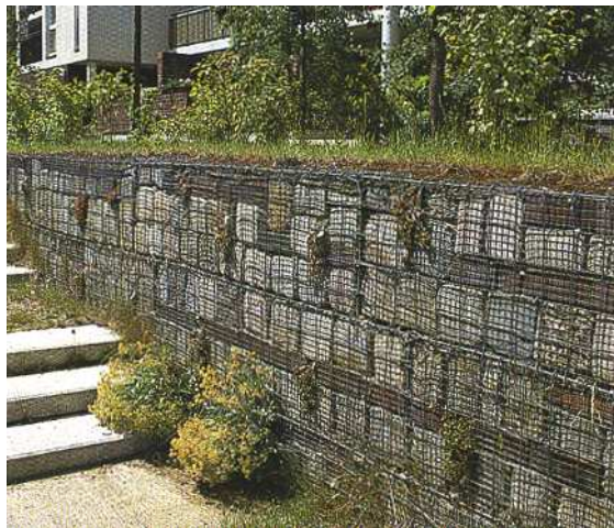
Muur opgebouwd met schanskorven
