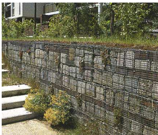
Mur constitué de gabions
