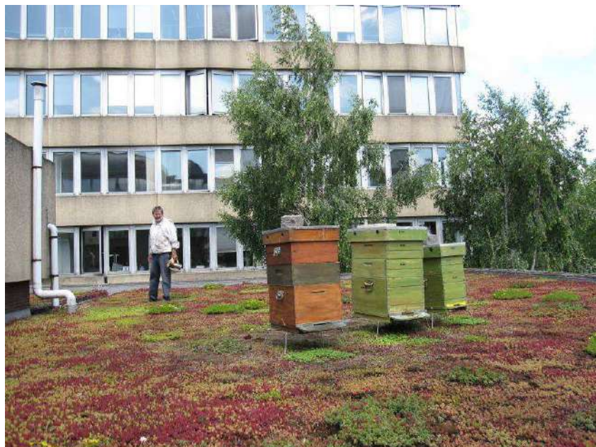
Toiture verte extensive et ruches, immeubles de bureaux de Bruxelles Environnement, Woluwe-Saint-Lambert.
