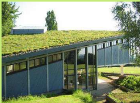
Toiture verte extensive – Source : Ecoworks
