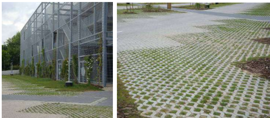
Aire perméable de parking avec dalles-gazon à Woluwe-Saint-Lambert (Caméléon)
