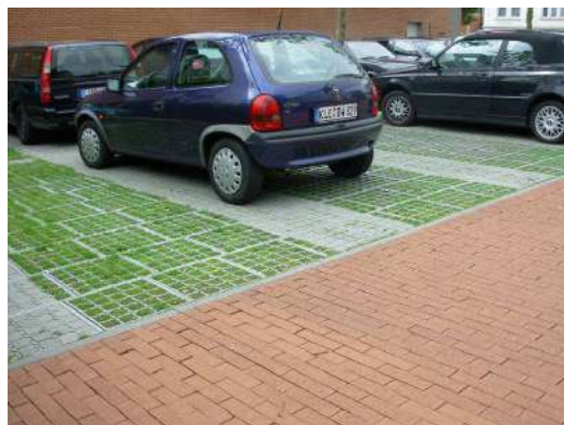
Aire perméable de parking avec dalles modulées pour gazon et pavés à joints ouverts à Herford (Allemagne)
